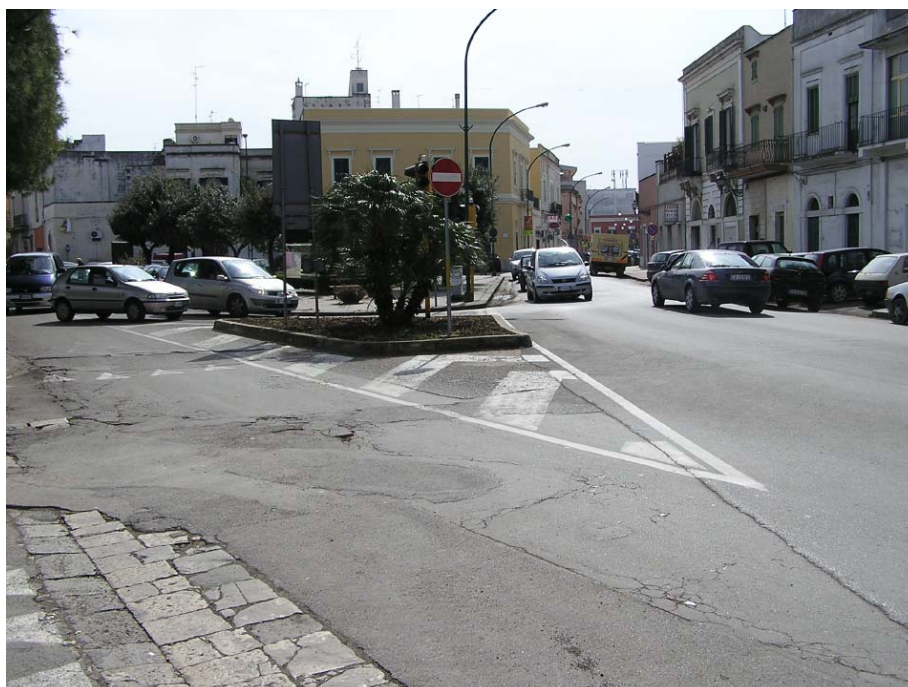
Fig. 1 – Sito di monitoraggio a Copertino (Marzo 2006).
