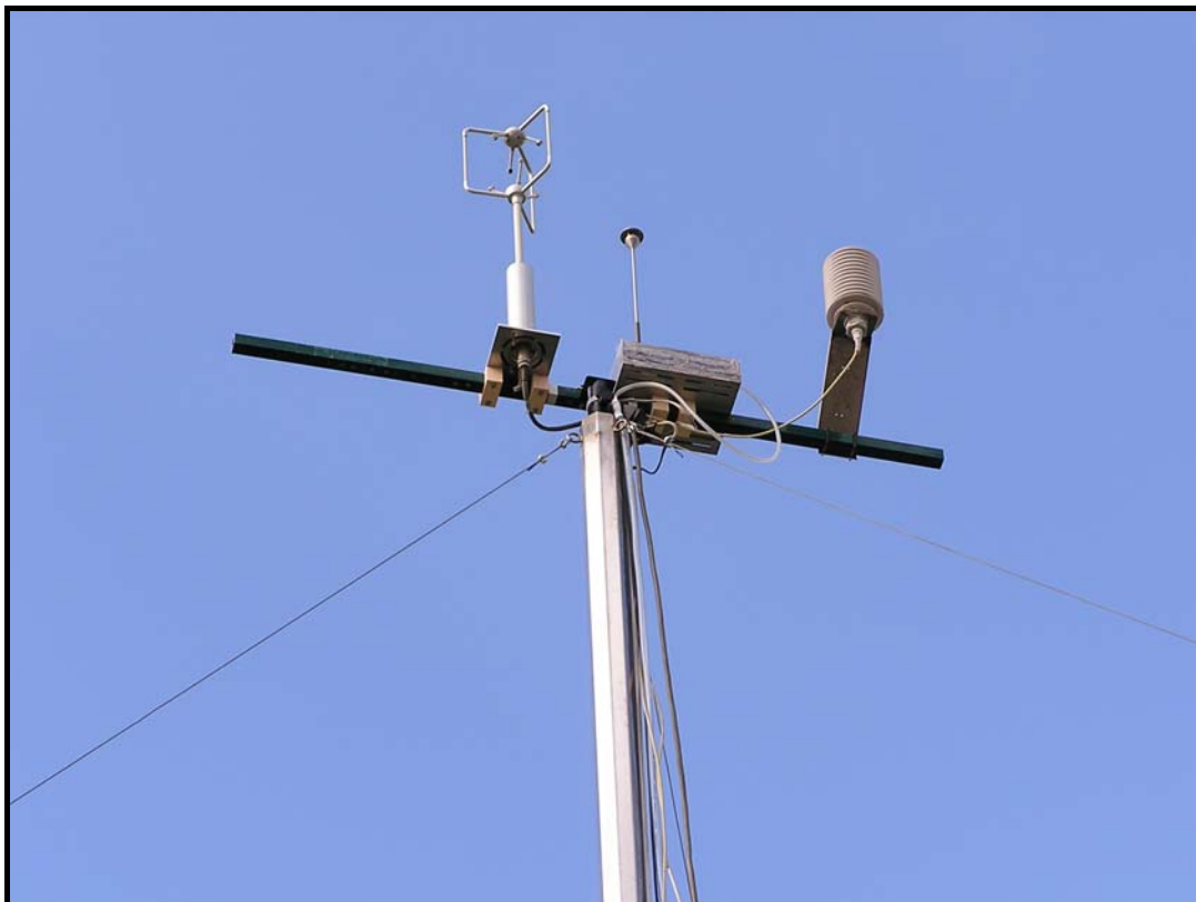
Fig. 5 – Anemometro e termoigrometro, in foto è visibile anche il pDR.
